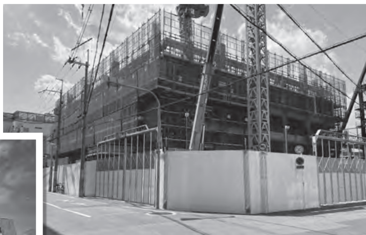
ジオタワー工事中 2026年5月完成予定
